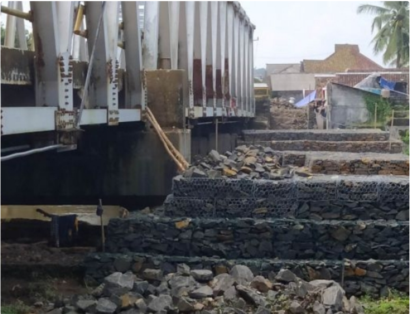
Pemasangan TPT dan Bronjong pada proyek jembatan Cisih
