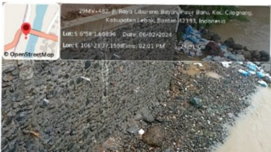
Foto Titik Lokasi Pembangunan Penahan Jembatan
